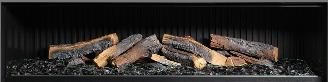
**Schritt 19:** Verteilen Sie das schwarze Glasgranulat rund um das gesamte Brennerbett, auch über dem klaren und dem schwarzen Harzgranulat. Sie müssen nicht das ganze im Lieferumfang enthaltene schwarze Glasgranulat verwenden.
