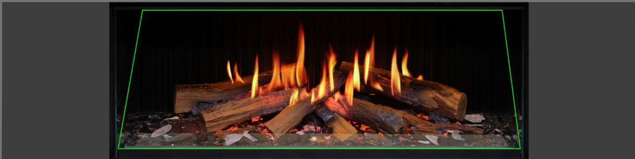
**Schritt 14:** Verteilen Sie die grauen und schwarzen Schiefer-Chips um das Brennerbett. Bringen Sie abschließend den Flammenschirm (schräge Glasscheibe) mit der richtigen Seite nach vorne wieder an. Prüfen Sie, ob die Flammen auf den Scheiten korrekt ausgerichtet sind.
