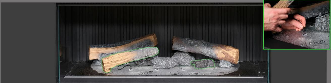
**Schritt 6:** Platzieren Sie die Scheite AI-27 und G2 auf den entsprechenden Umrissen auf dem Brennerbett, stecken Sie dabei jeweils den Zapfen an der Unterseite des Scheites in das dafür vorgesehene Loch und stecken Sie das Kabel in die am Brennerbett befindliche Buchse.
